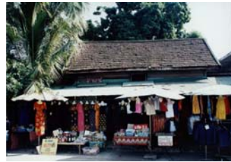
อาคารไม้ชั้นเดียว ลักษณะเป็นเรือนแถวค้าขาย โครงสร้างไม้ ผนังเกล็ดซ้อน หลังคามุงกระเบื้อง และสังกะสี
