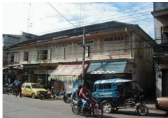
ลักษณะอาคารไม้ 2 ชั้น ลักษณะเป็นเรือนแถวค้าขาย โครงสร้างอาคารเป็นไม้ ผนังเกล็ดซ้อนไม้ หลังคามุงกระเบื้อง และสังกะสี เป็นอาคารเก่าบริเวณพื้นที่ศึกษา
