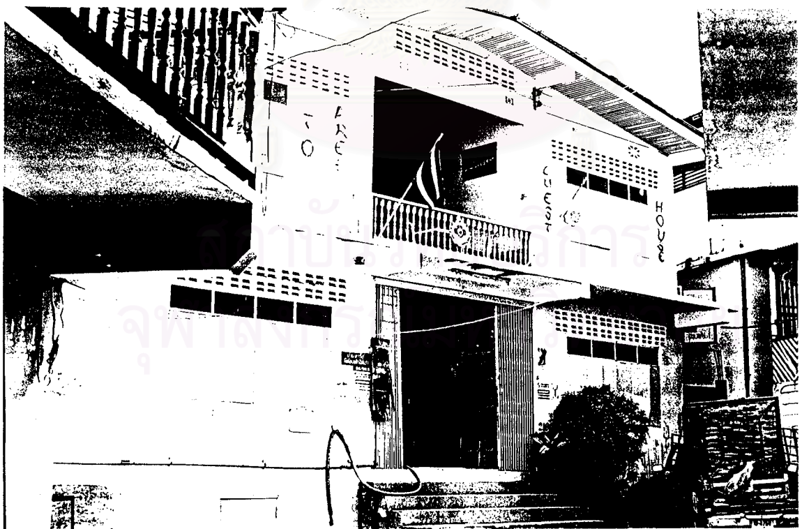
ภาพที่ 4.40 แสดงสภาพ บ้านพักอารีย์ (อาคาร ค.ส.ล. 2 ชั้น)
