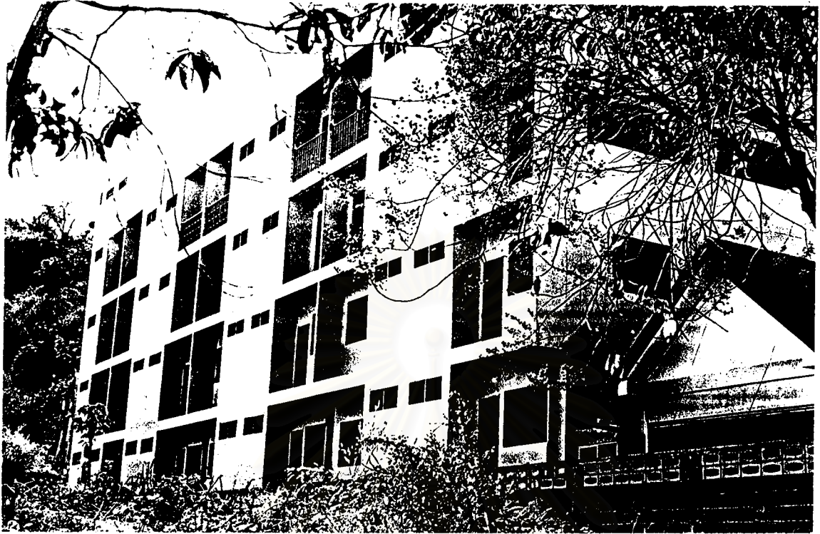
ภาพที่ 4.39 แสดงสภาพบ้านพัก สีซังชาวเขา (อาคาร ค.ส.ล. 4 ชั้น)
