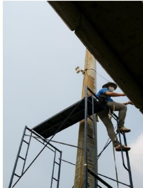
รูปที่ 3.12 ระบบบันทึกภาพ : กล้อง Mobotix M15 และการติดตั้ง
