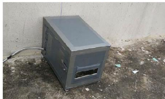
รูปที่ 3.10 ระบบตรวจจับเพลารถ (Axle Detector) และการติดตั้งที่สะพาน
