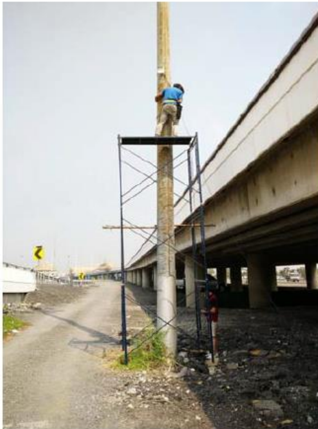
รูปที่ 3.12 ระบบบันทึกภาพ : กล้อง Mobotix M15 และการติดตั้ง
