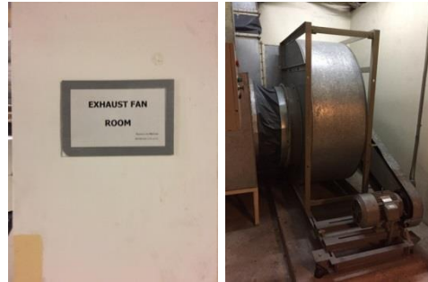
รูปที่ 35 งานระบบปรับอากาศ (Exhaust Fan)
