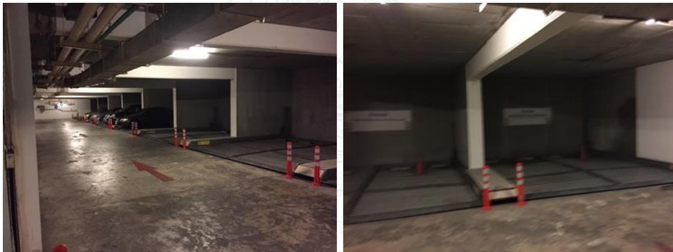
รูปที่ 20 ลานจอดรถชั้นใต้ดิน
