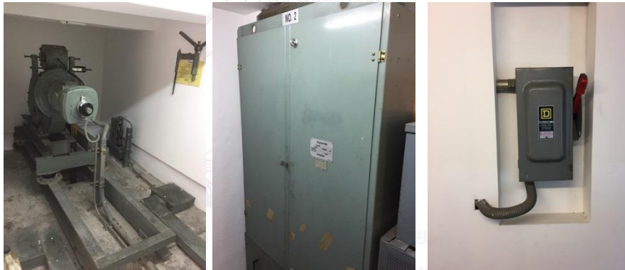
รูปที่ 40 งานระบบลิฟต์โดยสาร
