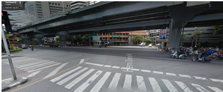
ข) ลักษณะของบริเวณทางแยกที่ติดตั้ง
