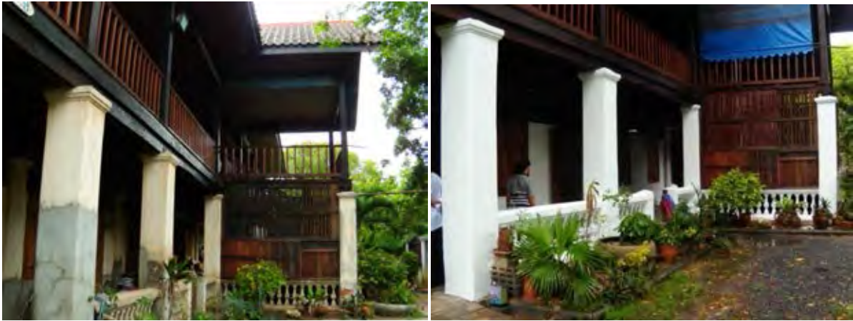
ภาพที่ 5.1-2 ลักษณะด้านหน้าอาคาร (ซ้าย)ก่อนการบูรณะ(ขวา)หลังการบูรณะ
