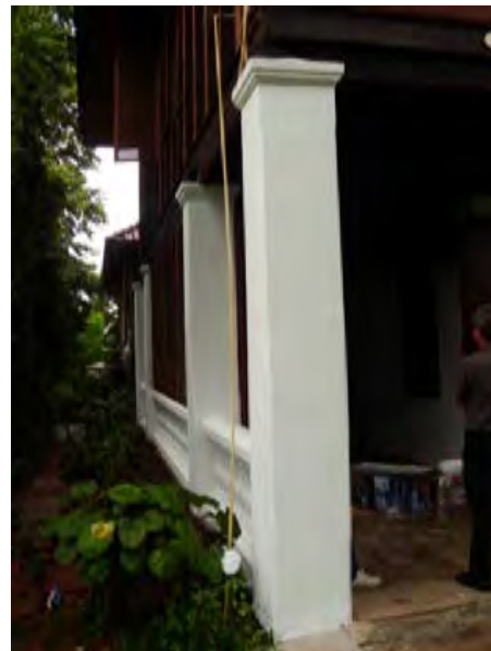
ภาพที่ 5.1-7 เสาชั้นล่าง ของบ้านพักพระสงฆ์ (ซ้าย)ก่อนการบูรณะ (ขวา)หลังการบูรณะ
