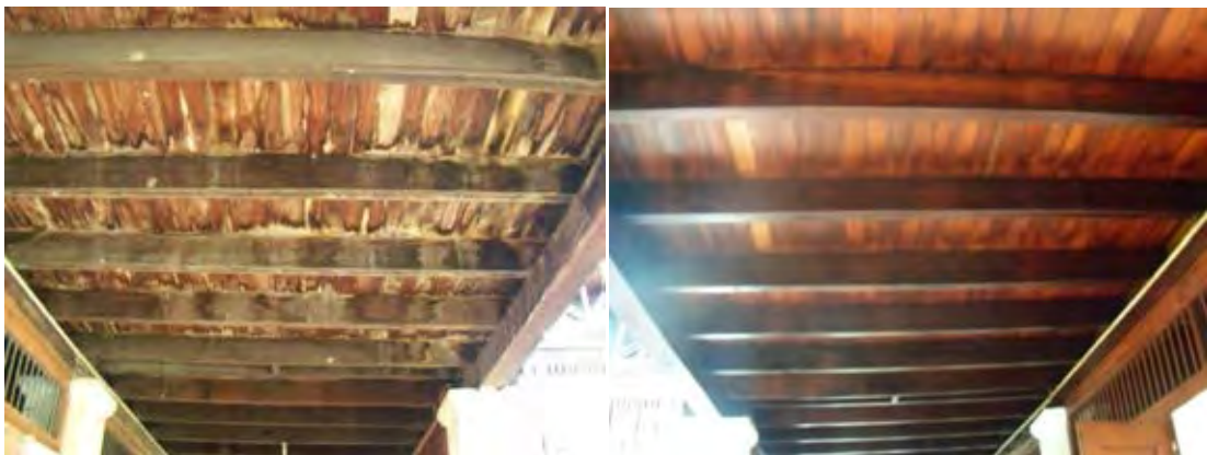
ภาพที่ 5.1-4 ใต้พื้นชั้น 2 ของบ้านพักพระสงฆ์ (ซ้าย)ก่อนการบูรณะ (ขวา)หลังการบูรณะ
