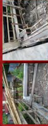
การบูรณะพื้นชั้นล่าง (ระหว่างการบูรณะ)
