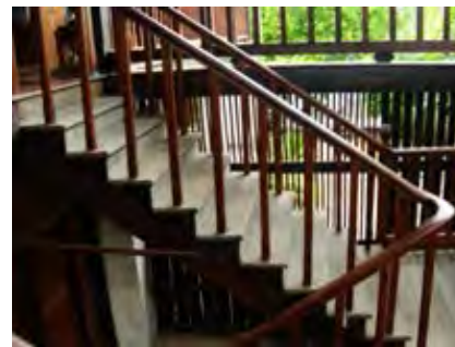
ชั้นบันไดและราวจับ
