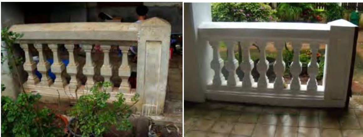
ภาพที่ 5.1-6 ระเบียงคอนกรีต ชั้นล่าง ของบ้านพักพระสงฆ์ (ซ้าย)ก่อนการบูรณะ (ขวา)หลังการบูรณะ
