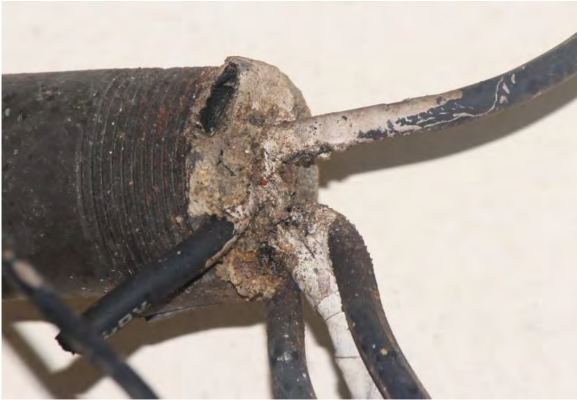
ภาพที่ 14 รังชันโรง Tetragonula pagdeni ที่ท่อทางเดินสายไฟบ้านพัก 259
