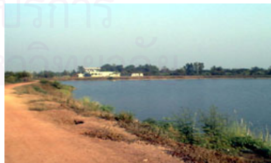
อาคารประปาและแหล่งน้ำ
