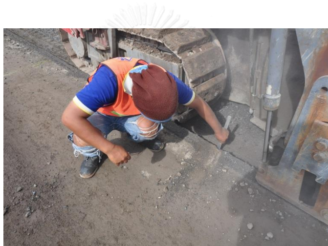
รูปที่ 4-6 ตรวจสอบความลึกของการขุดไล่
