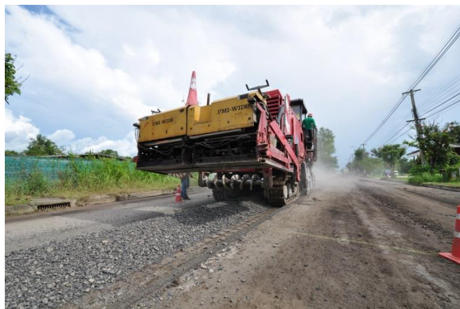
รูปที่ 4-7 วัสดุผิวทางเดิมที่ถูกขุดไล่แล้วกองอยู่กับพื้นถนน
