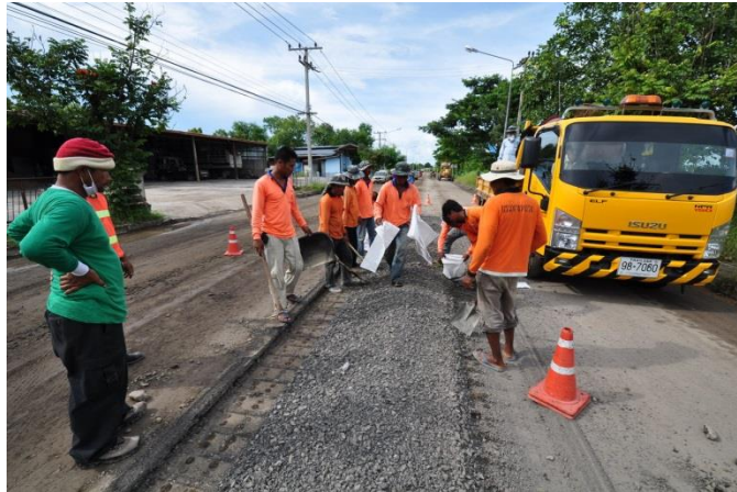
รูปที่ 4-8 เจ้าหน้าที่หมวดการทางศรีนครินทร์ กำลังโยยวัสดุผิวทางเดิมใส่กระสอบ
