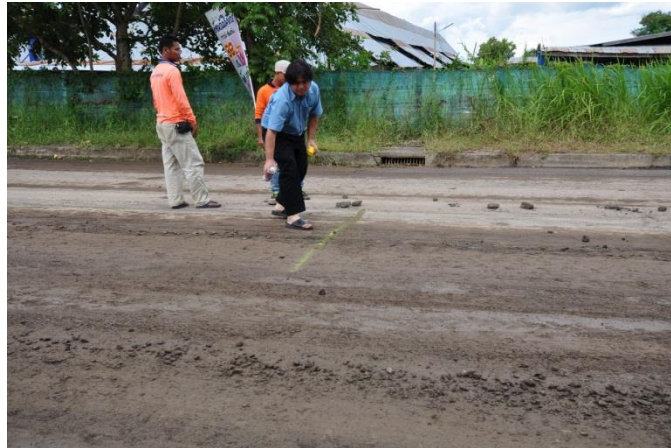
รูปที่ 4-3 กำหนดตำแหน่งเริ่มต้นและสิ้นสุดการขุดไส
