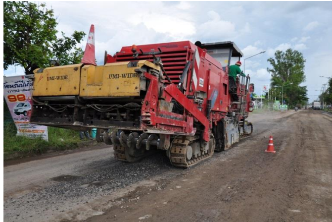
รูปที่ 4-10 ถอยเครื่องจักรรีไซเคิลมายังตำแหน่งเริ่มต้น เตรียมชุดใส่ชั้นพื้นทาง
