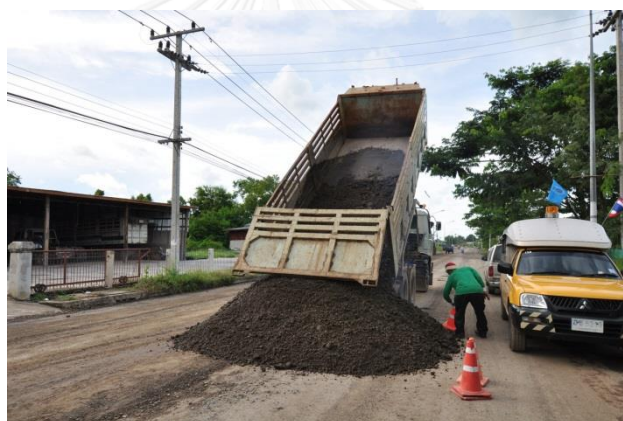
รูปที่ 4-14 นำวัสดุมาถมกลบหลุมที่เกิดจากการขุดไส
