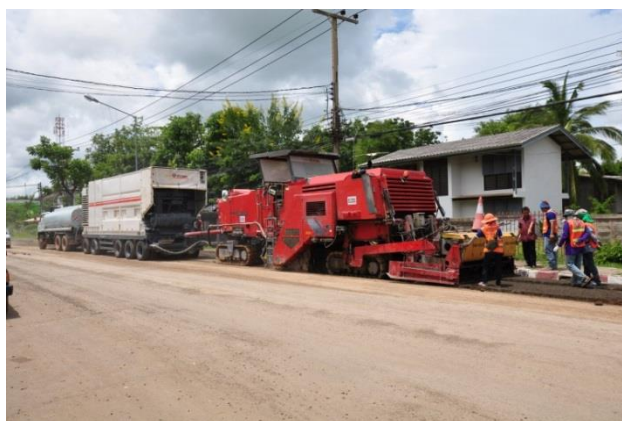
รูปที่ 4-16 เครื่องจักร Wirtgen W2200 ขณะทำงาน
