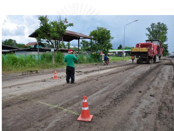
รูปที่ 4-4 ตั้งแนวเครื่องจักรรีไซเคิล
