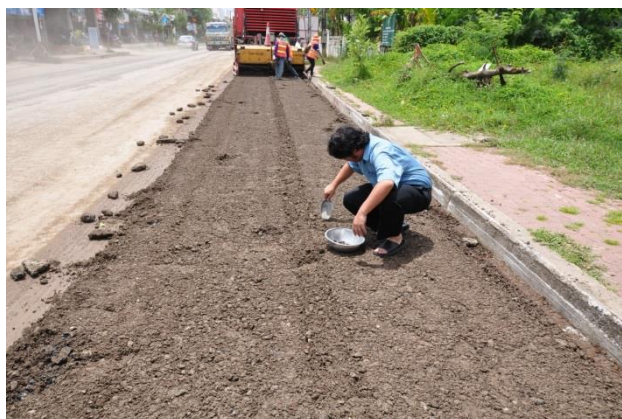
รูปที่ 4-17 เก็บตัวอย่างวัสดุที่ได้รับการปรับปรุงคุณภาพด้วยปูนซีเมนต์แล้ว
