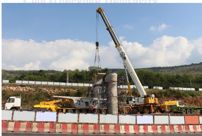
รูปที่ 5.5 กลุ่มเครื่องจักรที่ทำงานร่วมกันในงานยกชิ้นส่วนติดตั้ง
