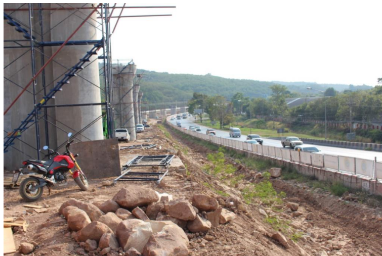
รูปที่ 2.2 งานขุดตัดดินทำทางระบายน้ำชั่วคราว
