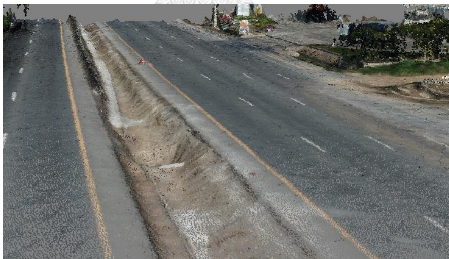
รูปที่ 5.16 โครงสร้างร่องระบายน้ำที่กึ่งกลางถนนทางหลวง และแฉกกัน
