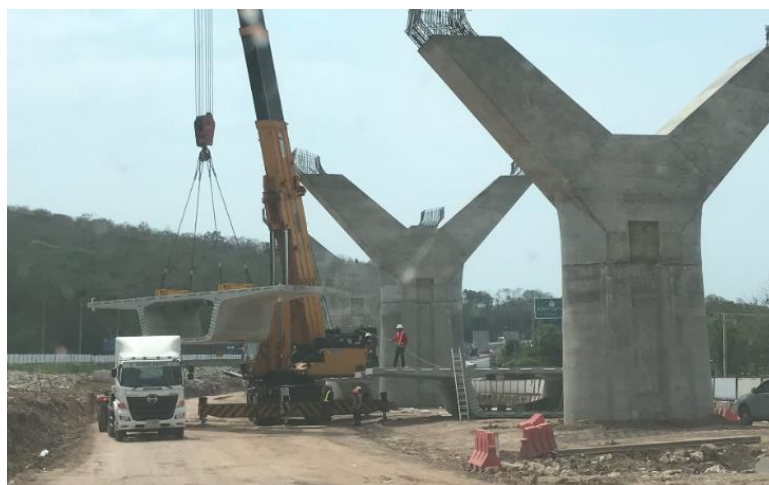
รูปที่ 5.3 รถปั้นจั่นกำลังทำงานยกชิ้นส่วน
