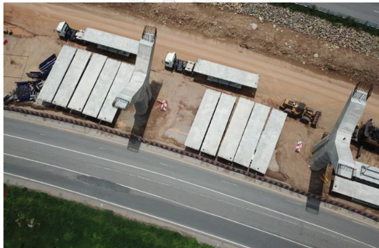
รูปที่ 5.2 การขนส่งและจุดกองเก็บชิ้นส่วนโครงสร้างสะพาน
