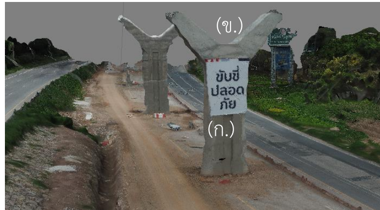
รูปที่ 5.12 เสาสะพานในแบบจำลองสภาพพื้นที่
