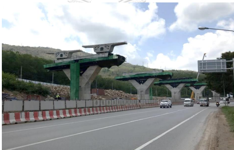
รูปที่ 5.4 โครงสร้างเสาคอนกรีตเสริมเหล็กแบบหล่อในที่ และคานสะพานชิ้นส่วนสำเร็จรูป
