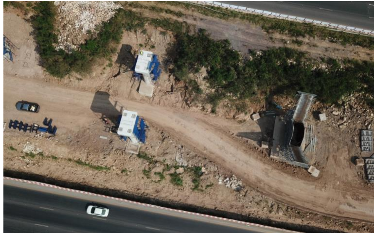
รูปที่ 5.1 เส้นทางขนส่งลำเลียงวัสดุและหล่อเสา
