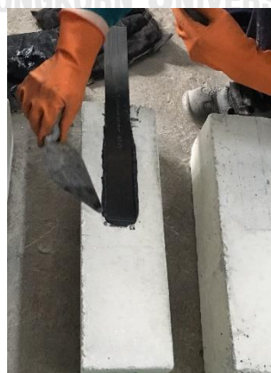
(ค) การติดตั้ง CFRP กับคอนกรีตตัวอย่าง
