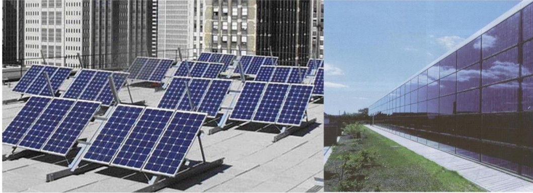
รูปที่ 2.35 ระบบเซลล์แสงอาทิตย์ติดตั้งด้านบน (ซ้าย) และผนัง (ขวา) ของอาคาร [14]
