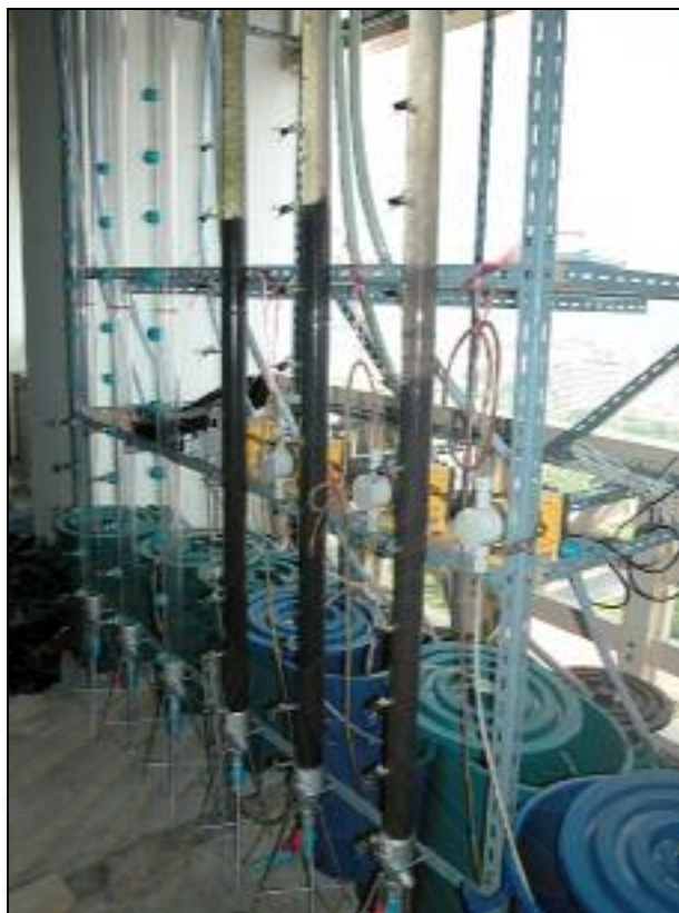
รูปที่ 3.5 ลักษณะการติดตั้งระบบยูเอเอสบี
