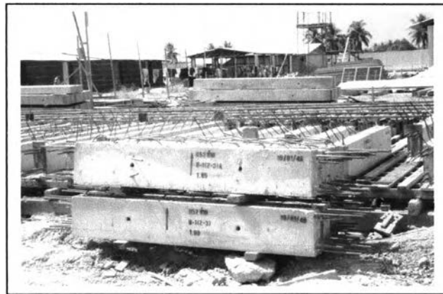
ภาพที่ 6 – 8 คานคอดินสำเร็จรูป (คานชอย)
