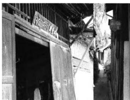
ภาพที่ 3-59 ป้ายชื่อร้าน อาคารเรือนแถวริมน้ำ
