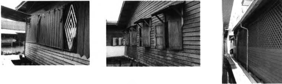
ภาพที่3-5 หน้าต่างแบบบานเปิดคู่ไม้และแบบเจาะช่องลม
