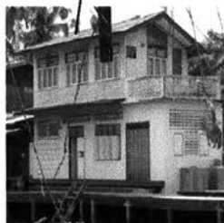
ภาพที่3-22 เรือนพื้นบ้านแบบที่มีความร่วมสมัย รูป ทรงสี่เหลี่ยมใช้โครงสร้างทั้งวัสดุไม้ และค.ส.ล
