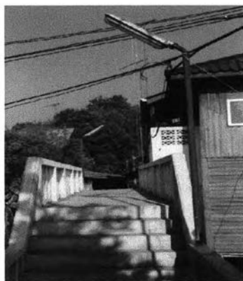
ภาพที่3-54 โคมเสาไฟบนสะพาน
