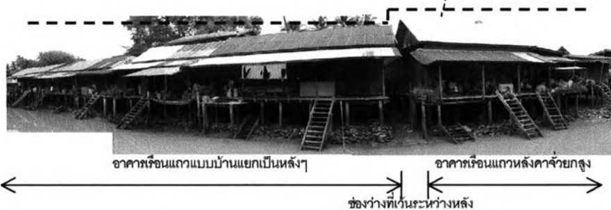
ภาพที่3-40 อาคารเรือนแถวไม้ ย่านพักอาศัยบริเวณโรงเจ
