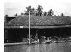
หลังคา รั้วแบบทรงปั้นหย่า หรือทรงจั่ว ควรใช้วัสดุ กระเบื้องสีที่เหลี่ยมขนมเปียกปูน มีองศา 30-45
