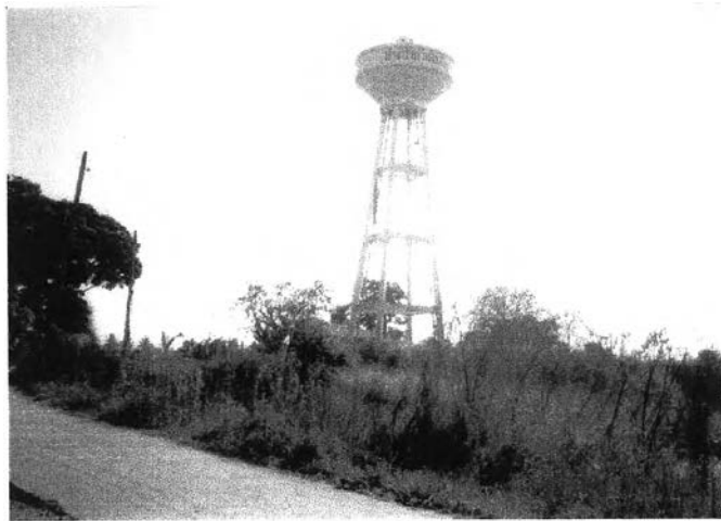
รูปภาพที่ 4 - 4 บ่อสูบน้ำบาดาลหมู่ที่ 3
