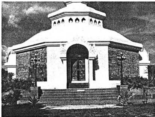
ภาพที่ 4.8.1.2 แสดงรูปแบบสถาปัตยกรรมส่วนตัวอาคาร ซึ่งยกพื้นไม่สูงมาก รัศด้วยบัวคว่ำและบัวหงายโดยรอบ
