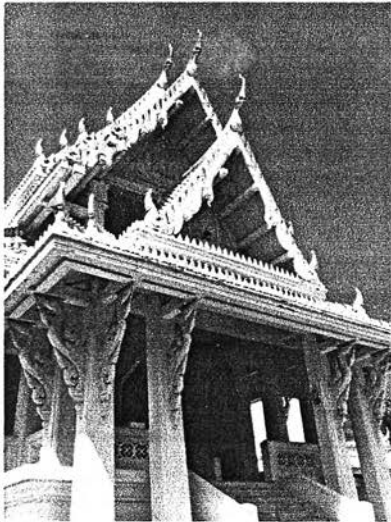
ภาพที่ 4.3.4.17 รูปแบบของหลังคาเป็นแบบจั่วเปิด ชั้น 2 ชั้น และมีหลังคามุขยื่นออกมาทางด้านหน้าสอดเข้าไปใต้โครงหลังคาหลัก
