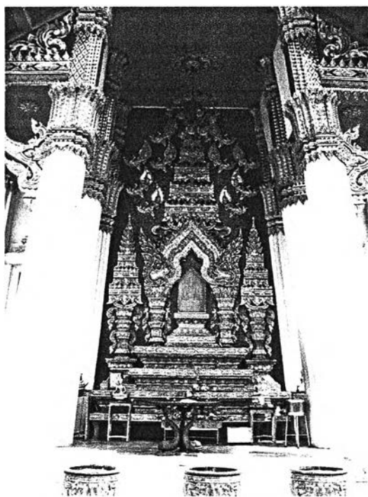
ภาพที่ 4.3.1.8 ผนังด้านหน้าพระวิหาร เป็นซุ้มปูนปั้นปิดทองประดับกระจกสี ประดับฉัตรด้านบนและด้านข้าง ผนังตอนบนเป็นรูปเทพชุมนุม
