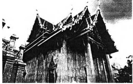
ภาพที่ 4.1.1.5 แสดงภาพด้านหลังพระอุโบสถ ผนังและเสาบุด้วยหินอ่อน บัวปลายเสาเปิดทองประดับกระจก
