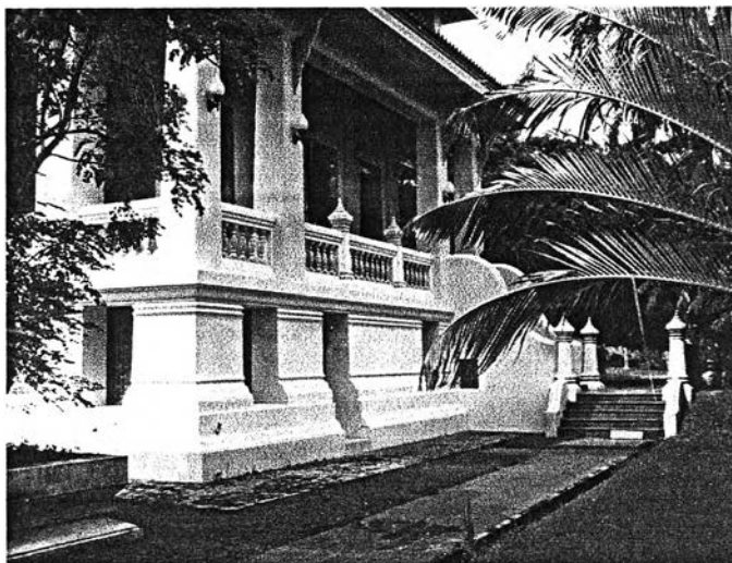
ภาพที่ 4.1.5.6 ตัวอาคารมีผนังตั้งตรง ประกอบด้วยเสาและลูกกรงรูปสี่เหลี่ยมจัตุรัส ระหว่างเสามีราวกันตกและลูกกรง
