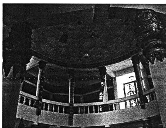
ภาพที่ 4.3.3.16 รูปแบบสถาปัตยกรรมภายในชั้นที่ 2 มีลักษณะเหมือนเป็นชั้นลอยหรือพื้นระเบียง สามารถเดินได้ โดยรอบ กันด้วยราวกันตกประกอบลูกกรง เพดานรูปวงกลมโค้งคล้าย Dome เขียนสีเป็นรูปท้องฟ้า วิมาน และเทวดา
