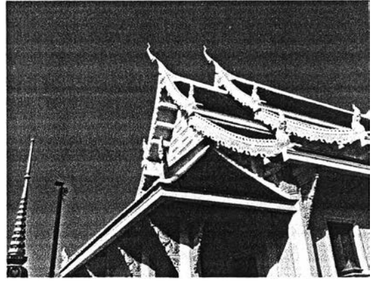
ภาพที่ 4.8.2.11 แสดงหลังคาด้านหลังอาคารซึ่งเป็นแบบจั่ว ปิดตามความเหมาะสมของการใช้งาน
