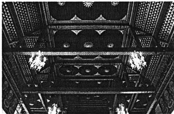
ภาพที่ 4.1.1.20 แสดงรูปแบบโครงสร้างหลังคาซึ่งเป็นโครงเหล็ก และหุ้มด้วยไม้ประดับตกแต่งเขียนลวดลาย
