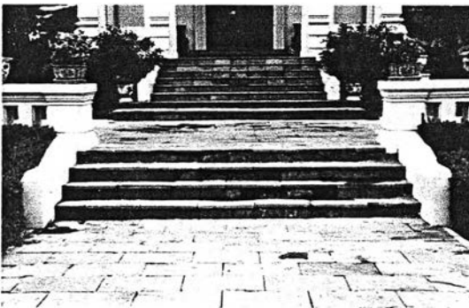
ภาพที่ 4.4.1.6 บันไดทางขึ้นด้านหน้าพระอุโบสถ ประกอบด้วยพนักพลสิงห์
