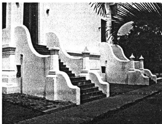
ภาพที่ 4.1.5.5 บันไดทางมุขด้านหลัง มี 2 ช่วง มีรูปแบบเหมือนกับบันไดด้านหน้าและด้านข้าง แต่ความสูงมากกว่า และต่อพนักบันไดลงมาอีกชั้นหนึ่ง เนื่องจากพื้นที่ทางด้านหลังอาคารมีความลาดต่ำกว่าทางด้านหน้า
