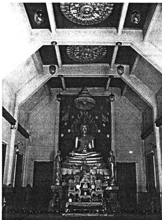
ภาพที่ 4.7.3.12 ภายในพระอุโบสถแสดงลักษณะโครงสร้างแบบ Rigid Frame ทำให้ไม่มีเสาร่วมใน และช่วยเพิ่มความสูงของห้องโดยยกฝ้าเพดานขึ้นสูงในระดับคอสอง
