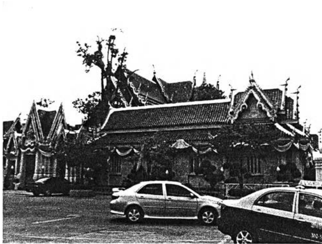
ภาพที่ 4.1.1.33 ทศนียภาพพระระเบียงคดทางด้านหน้า ซึ่งยกหลังคามุขบริเวณมุมอาคารและทางเข้าด้านข้าง
