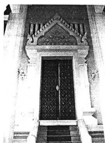
ภาพที่ 4.3.5.10 ซุ้มประตูทรงบันแถลง บานประตูทองแดงดูคล้ายลวดลายพฤกษชาติ เช่นเดียวกับหน้าต่าง
