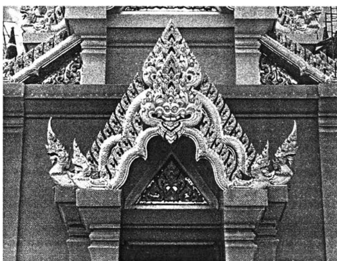
ภาพที่ 4.1.3.8 ยอดชุ่มเป็นรูปหน้าภาพ ปลายลายเป็นลายนาค ลงรักปิดทอง เป็นรูปแบบเดียวกันหมดทั้งอาคาร
