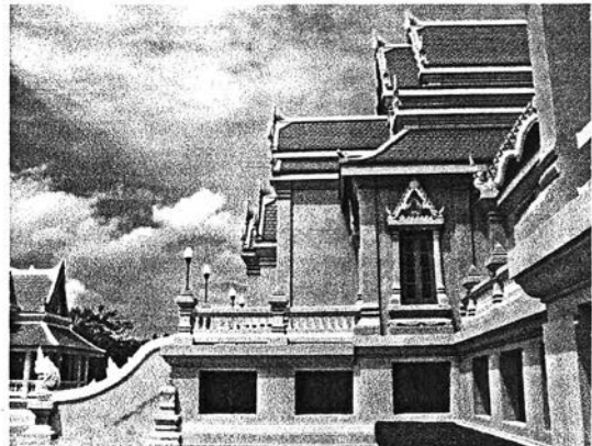
ภาพที่ 4.1.3.4 ฐานอาคารชั้นล่างเป็นฐานบัวคว่ำบัวหงาย วัสดุเป็นทรายล้าง เจาะช่องหน้าต่างกระจกโดยรอบ มีบันไดนาคเป็นบันไดทางขึ้น
