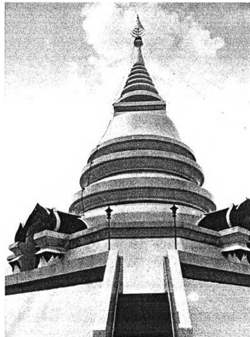
ภาพที่ 4.3.3.12 พระเจดีย์ทรงระฆัง ตั้งบนฐานแปดเหลี่ยม ประกอบด้วยชั้นมาลัยเถา องค์ระฆัง ต่อด้วยชั้นบัลลังก์สี่เหลี่ยมจัตุรัส ต่อด้วยปล้องไฉนจำนวน 5 ชั้น ปลียอด และลูกแก้ว ประดับยอดด้วยฉัตร 7 ชั้น
