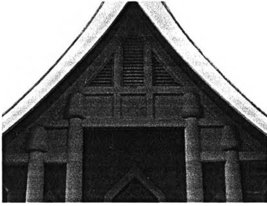
ภาพที่ 4.5.1.2 หน้าจั่วแบบบานเกล็ดช่วยการระบายอากาศ
