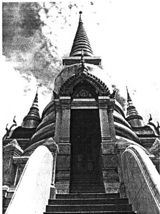
ภาพที่ 4.1.1.29 รูปแบบขององค์พระเจดีย์ประธานเป็นเจดีย์ทรงระฆัง ตั้งบนฐานหินอ่อน มีชุ่มจรมันทั้ง 4 ทิศ ส่วนยอดเป็นชั้นบัลลังก์ เสารับ ปล้องไฉน ปลียอด และลูกแก้ว
