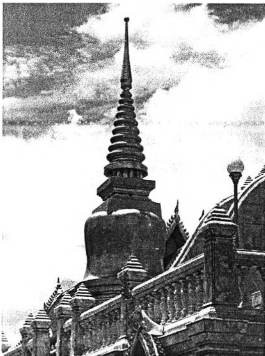
ภาพที่ 4.1.1.27 รูปแบบองค์พระเจดีย์บริวาร เป็นพระเจดีย์ทรงระฆัง บุนนาคด้วยกระเบื้องโมเสกสีทอง มีลักษณะเหมือนกับพระเจดีย์ประธานแต่ขนาดเล็กกว่า
