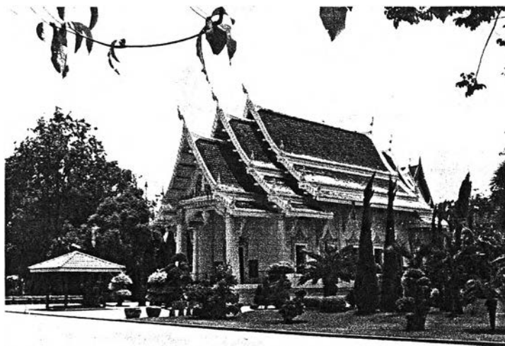
ภาพที่ 4.3.8.9 รูปแบบหลังคาแบบจั่วเปิด ซ้อน 3 ชั้น โดย 2 ชั้นบนมี 3 ตับ และหลังคามุข 2 ตับ วัสดุมุงหลังคาเป็นกระเบื้องดินเผาจากบักลัยสีน้ำเงินเข้ม
