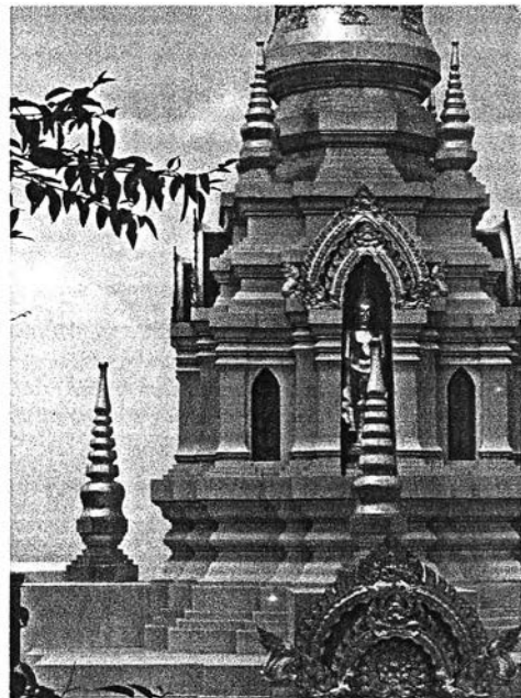
ภาพที่ 4.1.2.21 ด้านข้างซุ้มพระชนาบด้วยช่องแสง ที่ด้านหน้าของซุ้มพระตั้งเป็นเจดีย์บริวารตรงกับแกนกลาง
