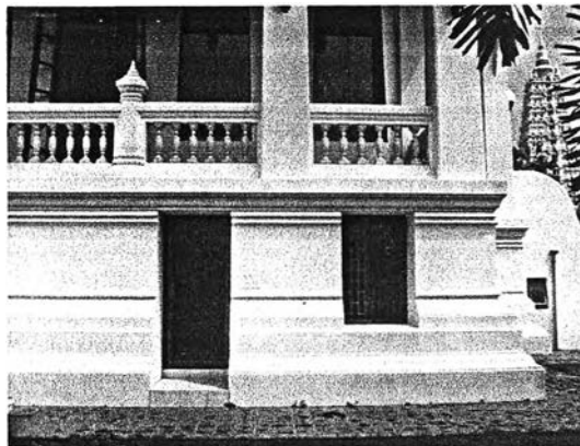
ภาพที่ 4.1.5.3 ส่วนฐานชั้นล่างใช้เป็นห้องอเนกประสงค์และเก็บของ มีรูปแบบเป็นฐานปัทม บานประตูและบานหน้าต่างเป็นกระจกรอบอคูมินิกยมสีขาว
