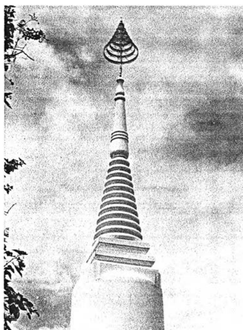
ภาพที่ 4.7.3.18 แสดงรูปแบบขององค์ระฆังและส่วนยอดเจดีย์ บนสุดประดับด้วยฉัตร 5 ชั้น
