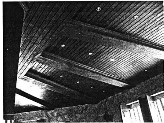
ภาพที่ 4.3.2.8 ฝ้าเพดานไม้ตีเป็นแนวนวรีศิมของรูปแปดเหลี่ยมประดับโคมไฟ Down Light
