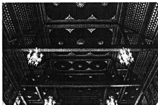
ภาพที่ 4.1.1.17 รูปแบบของโครงหลังคา ซึ่งภายในเป็นโครงเหล็กและหุ้มภายนอกด้วยไม้ประดับด้วยลายฉลุปิดทอง ที่ฝ้าเพดานประดับดาวเพดานปิดทอง
