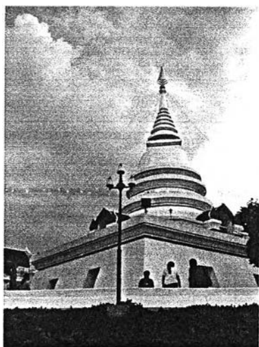
ภาพที่ 4.3.3.17 การใช้สีภายนอกเป็นการบุผิวอาคารด้วยกระเบื้องเซรามิกสีขาวทั้งหมด เพื่อสะดวกในการดูแลรักษาและซ่อมบำรุง อีกทั้งยังสื่อความหมายถึง ความสะอาด บริสุทธิ์
