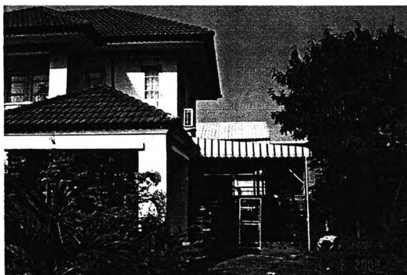
ภาพที่ 4.180 แสดงโรงจอดรถที่ทำการต่อเติมเปลี่ยนแปลงแล้ว
