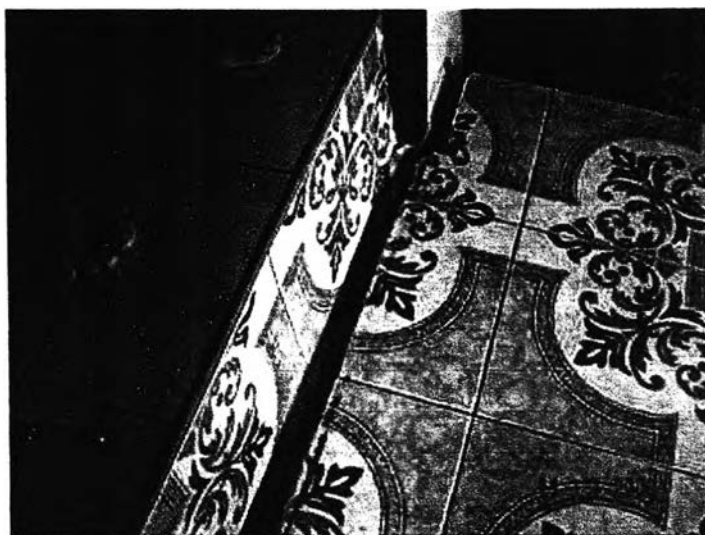
ภาพที่ 4.146 แสดงปัญหาภายหลังการต่อเติม
