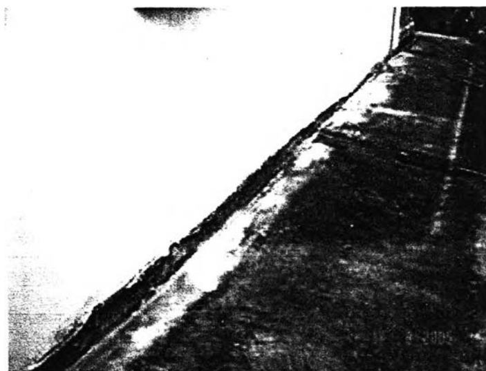
ภาพที่ 4.51 แสดงพื้นที่ห้องครัวที่พบปัญหารอยแยกจากผนัง
