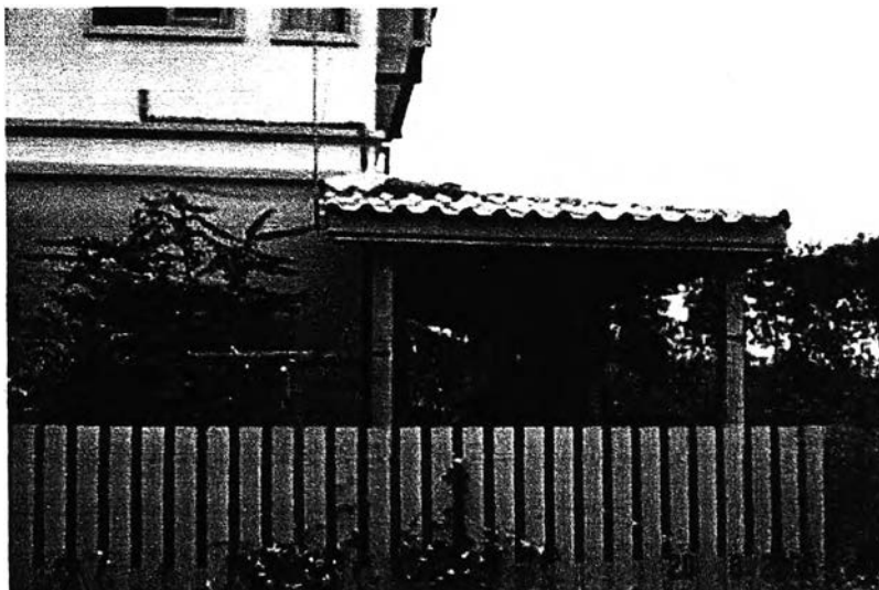
ภาพที่ 4.211 แสดงส่วนที่ทำการต่อเติมกับอาคารเดิม
