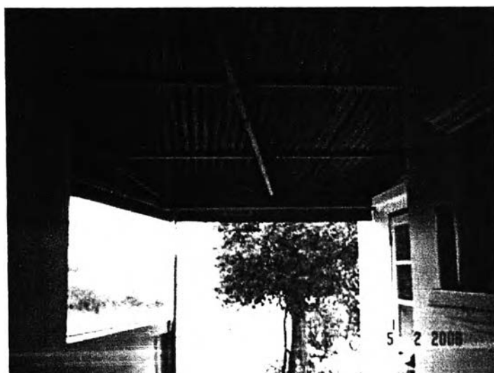
ภาพที่ 4.40 แสดงโครงสร้างหลังคาห้องครัวที่ทำการต่อเติมเปลี่ยนแปลง
