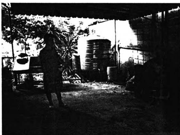
ภาพที่ 4.130 แสดงลานซักล้างที่ทำการต่อเติมเปลี่ยนแปลงแล้ว
