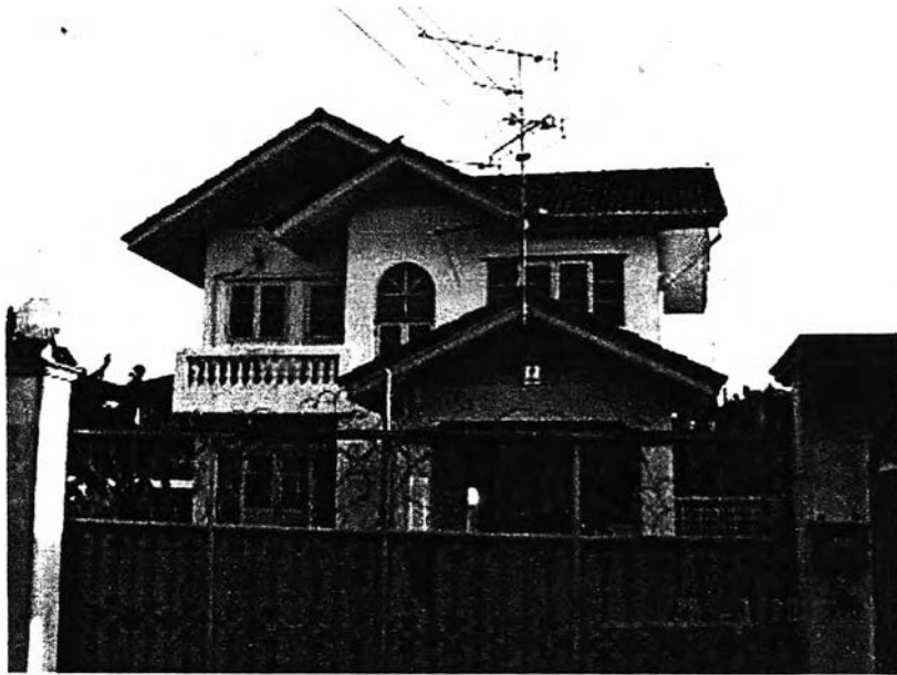
ภาพที่ 4.82 แสดงบ้านพักอาศัย PS 268
