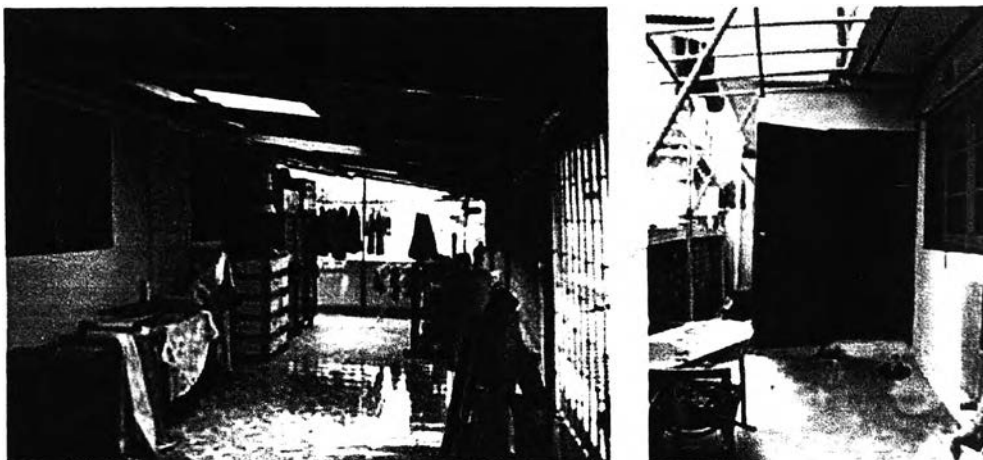
ภาพที่ 4.144 แสดงลานซักล้างที่ทำการต่อเติมเปลี่ยนแปลงแล้ว
