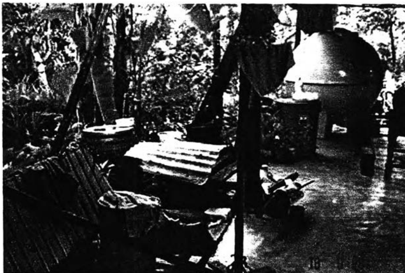
ภาพที่ 4.69 แสดงทางเดินรอบบ้านที่ทำการเทพื้นใหม่
