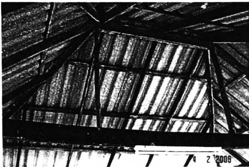
ภาพที่ 4.235 แสดงโครงสร้างโรงจอดรถที่ทำการต่อเติมเปลี่ยนแปลง
