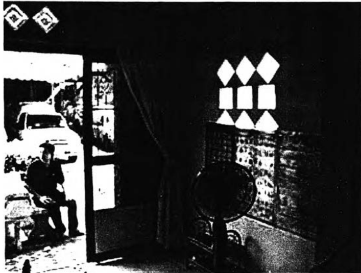
ภาพที่ 4.18 แสดงพื้นที่ภายในห้องรับแขกที่ทำการต่อเติมเปลี่ยนแปลงแล้ว
