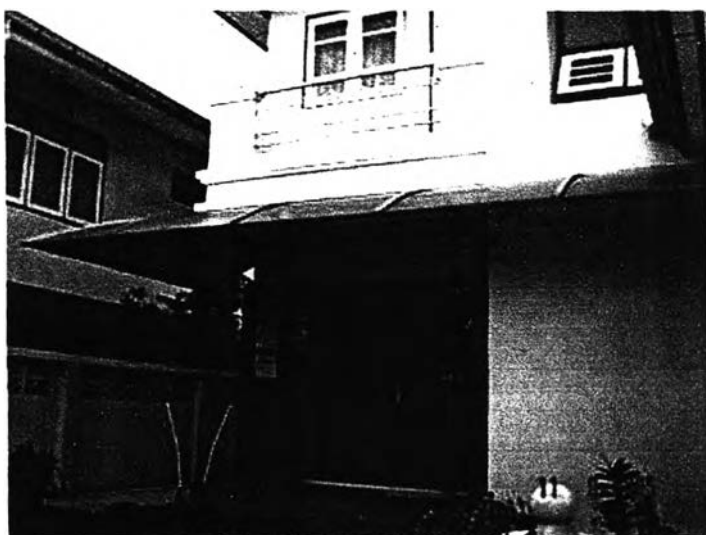
ภาพที่ 4.99 แสดงการติดตั้งแผ่นพลาสติกกันสาดบริเวณหน้าบ้าน
