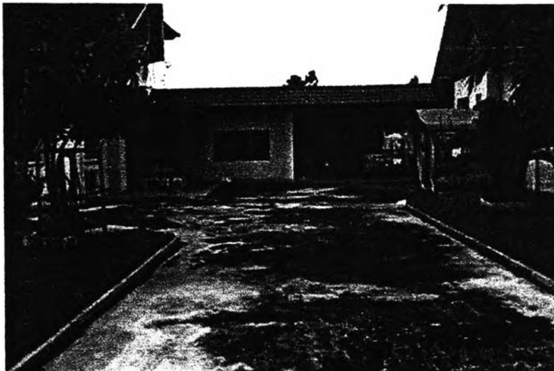
ภาพที่ 4.198 แสดงโรงจอดรถที่ทำการต่อเติมเปลี่ยนแปลงแล้ว
