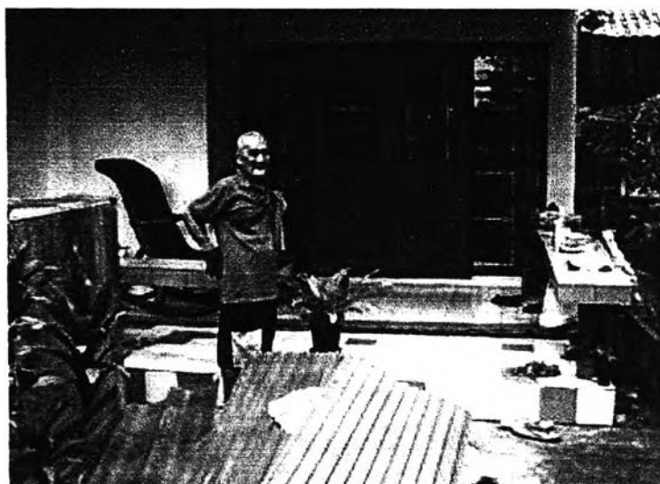
ภาพที่ 4.68 แสดงบริเวณเฉลียงหน้าบ้านที่ทำการต่อเติม
