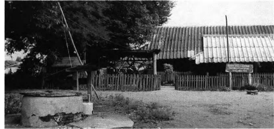
สนามเด็กเล่นบริเวณศูนย์อบรมเด็กก่อนเกณฑ์บ้านยางหลวงก่อนได้รับการปรับปรุง
