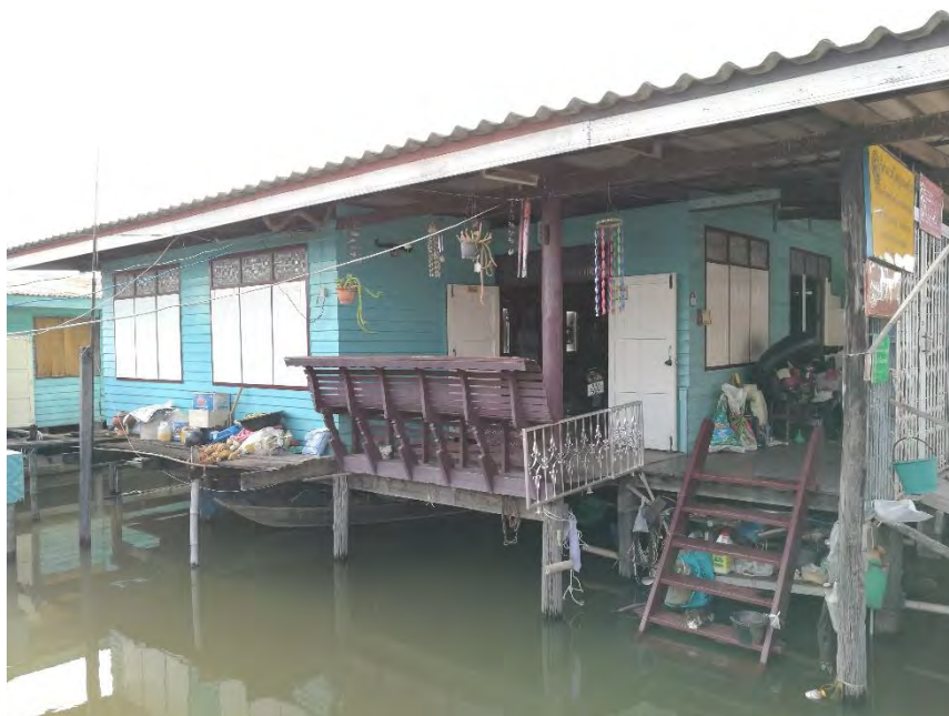
ภาพที่ 3-13 ลักษณะบ้านเรือนยกเสาสูงในชุมชนลาดชะโด
