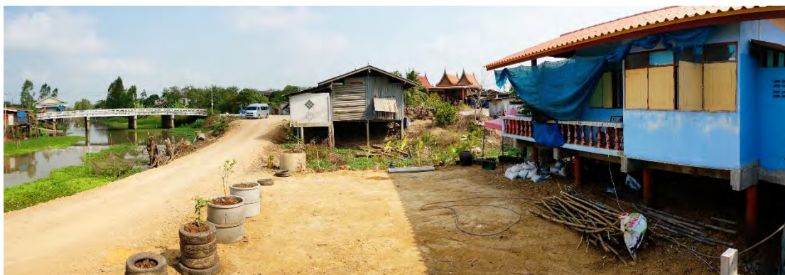
ภาพที่ 5-12 การตัดถนนริมคลองบางคี่ ที่มา : ถ่ายเมื่อวันที่ 24 กุมภาพันธ์ 2562
