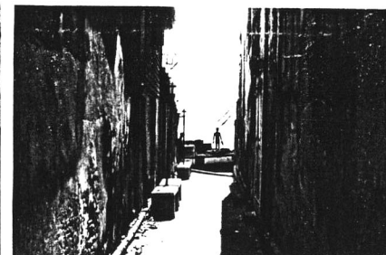
มุมมองจากช่องว่างริมาอาคารถนนคอนนอก
