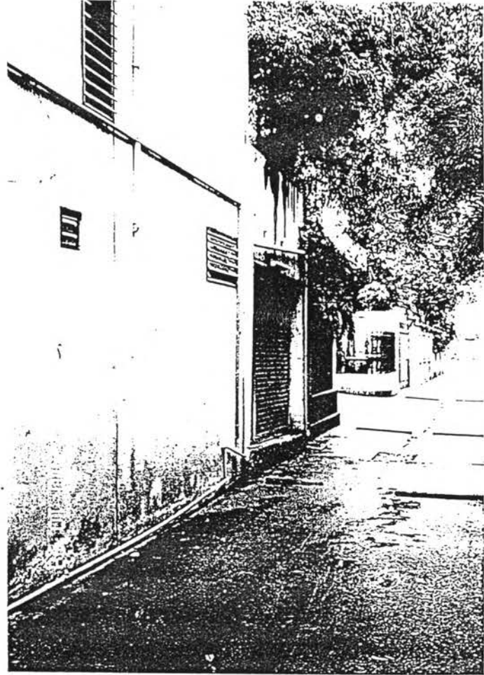
ภาพประกอบที่ 2.1 สภาพการมีอาคารที่ผิดหลักเกณฑ์ที่กฎหมายควบคุมอาคารกำหนด
