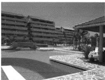
ภาพที่3.13 แสดงภาพอาคารพักอาศัย
