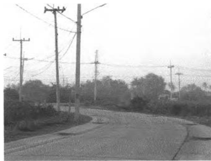
ภาพที่3.7 แสดงทางเข้าจากเส้นทางที่ 2 เป็นถนน 1เลนกว้าง 4เมตร (3 ก.พ. 49)
