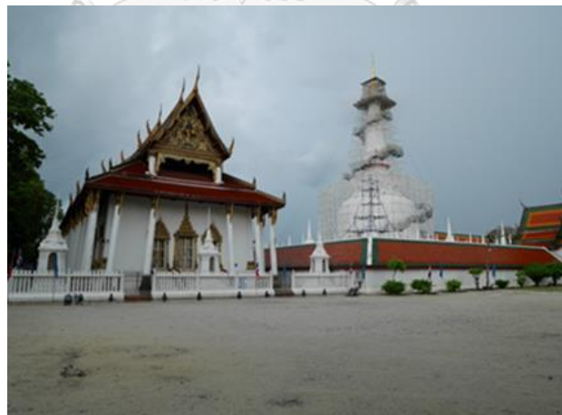
ภาพที่ 8 สภาพลานทรายหลังการปรับปรุง
