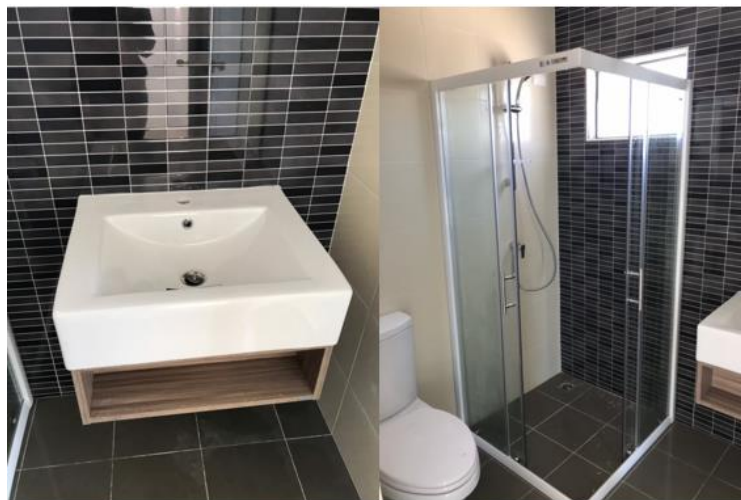
ภาพที่ 38 งานติดตั้งอุปกรณ์และสุขภัณฑ์ภายในห้องน้ำ
