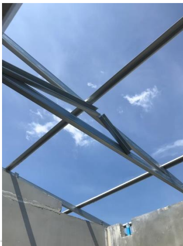
ภาพที่ 29 งานติดตั้งโครงหลังคา
