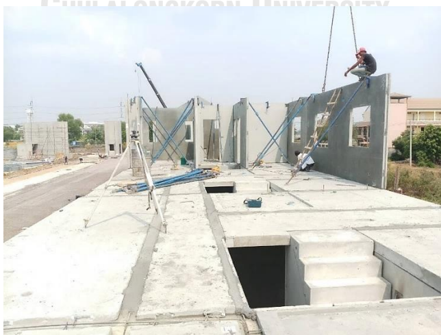
ภาพที่ 26 งานติดตั้งผนังชั้นบน
