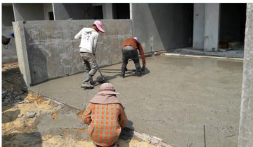
ภาพที่ 28 งานเทพื้นคอนกรีตโรงจอดรถ
