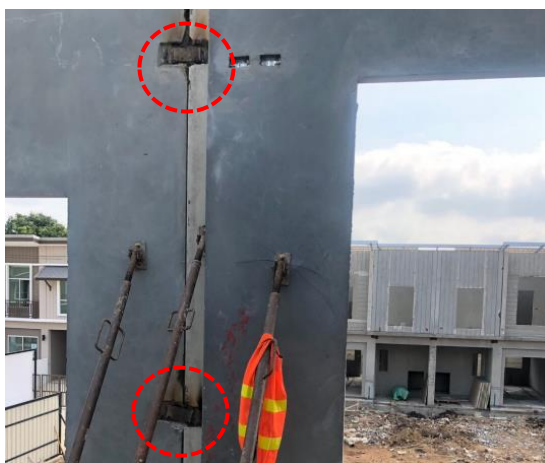
ภาพที่ 46 การใช้เพลทเหล็กบริเวณรอยต่อระหว่างผนังภายใน
