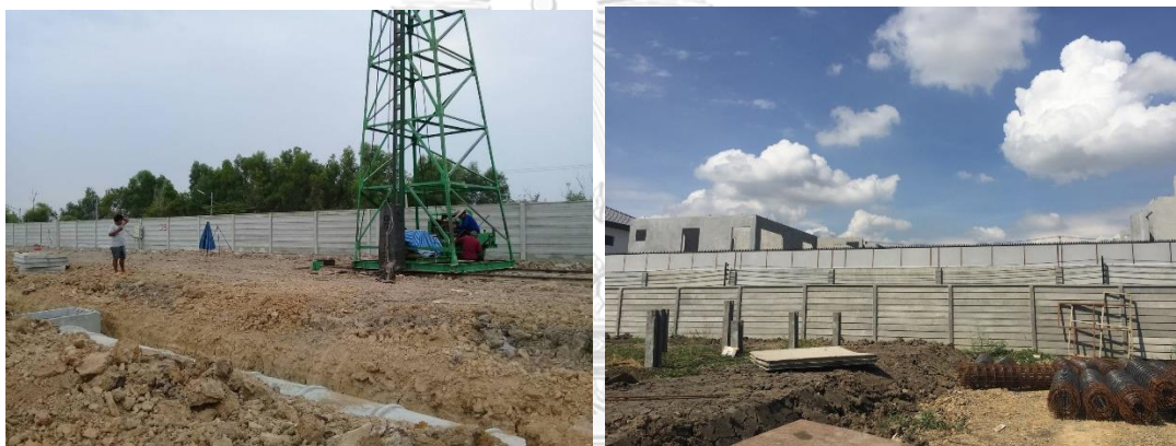
ภาพที่ 21 งานตอกเสาเข็ม
