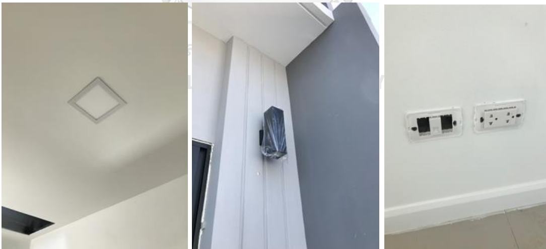
ภาพที่ 42 งานติดตั้งอุปกรณ์ไฟฟ้าต่างๆ
