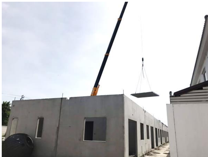
ภาพที่ 25 งานติดตั้งพื้นชั้นบน
