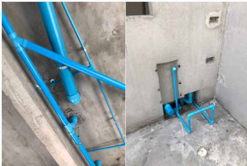
ภาพที่ 27 งานเดินท่อระบบสุขาภิบาล
