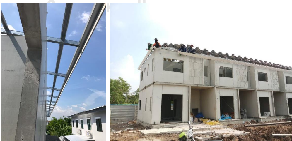
ภาพที่ 30 งานปิดเชิงชายและมุงหลังคา
