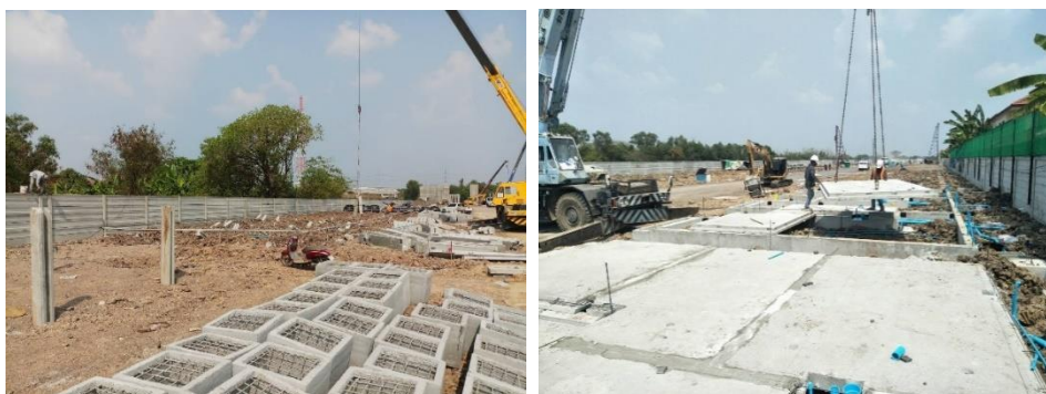
ภาพที่ 22 งานพื้นชั้นล่าง
