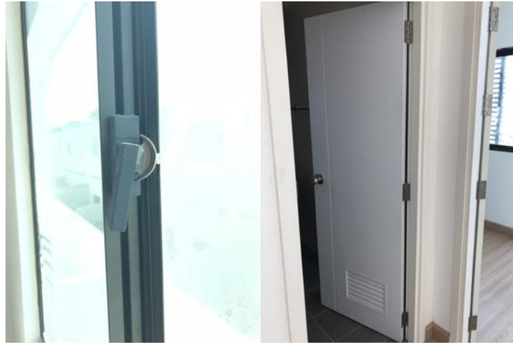
ภาพที่ 37 งานติดตั้งวงกบประตู-หน้าต่าง
