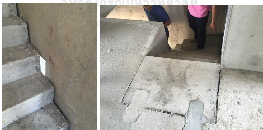
ภาพที่ 24 งานติดตั้งบันไดคอนกรีตสำเร็จรูป
