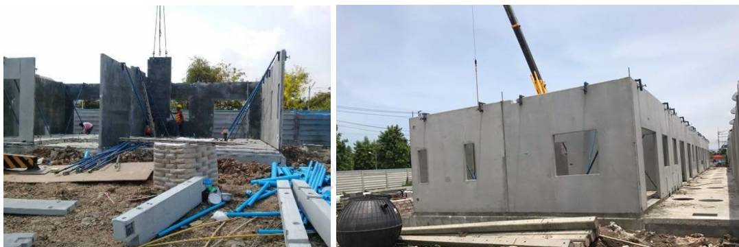
ภาพที่ 23 งานติดตั้งผนังชั้นล่าง
