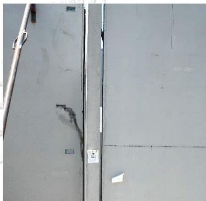
ภาพที่ 44 รอยต่อระหว่างแผ่นผนัง
