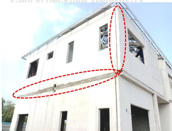
ภาพที่ 47 การใช้ปูนซีเมนต์ไม่หดตัวบริเวณรอยต่อผนังภายนอก
