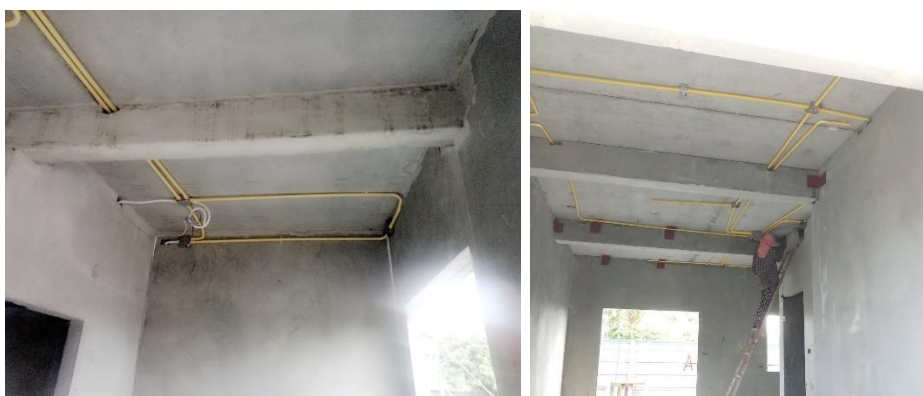
ภาพที่ 32 งานเดินท่อร้อยสายไฟฟ้า
