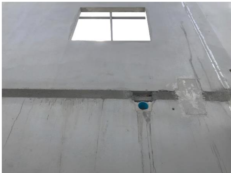
ภาพที่ 31 งานเชื่อมปิดผสานรอยต่อและเก็บงานปูน
