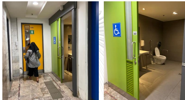
ภาพที่ 4.26-4.27 ภาพแสดงการจัดให้มีห้องน้ำแยกสำหรับผู้สูงอายุและคนพิการ มีการติดตั้งอุปกรณ์ ราวจับ และมีสัญลักษณ์บอกอย่างชัดเจน
