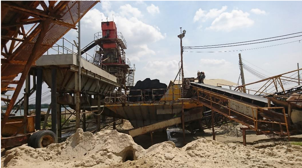
รูปที่ 3.5 ภาพบริเวณโรงล้างทราย บ่อทรายซีแพคสีร้อย
