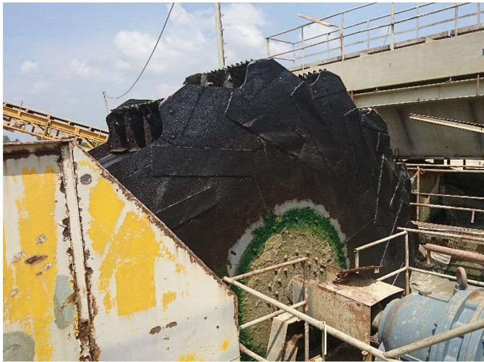
รูปที่ 2.14 เครื่องคัดขนาดบุงกีหมุนที่ใช้ในบ่อทรายซีแพคสีร้อย
