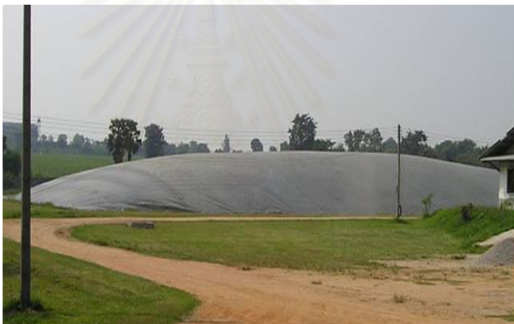
รูปที่ 10 แสดงลักษณะของระบบไบโอแก๊สแบบบ่อคลุม (Covered lagoon)
