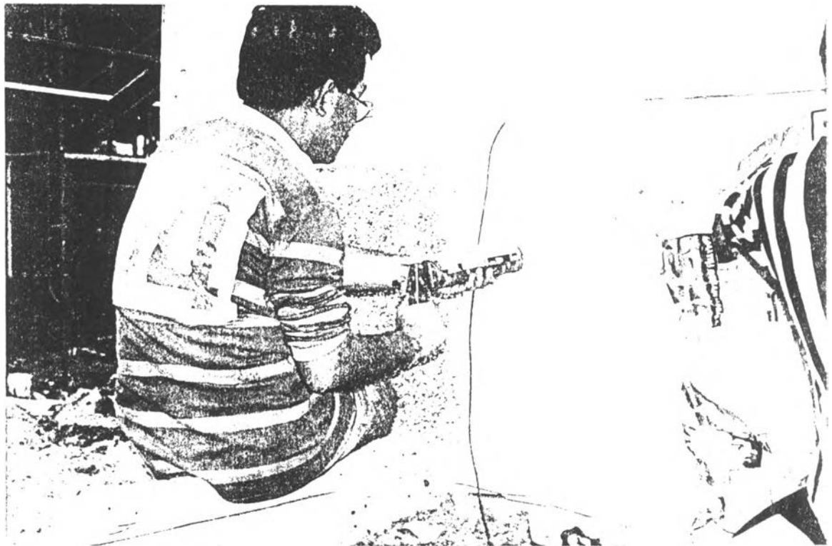
ภาพที่ 13 การอุดรอยรั่วของอาคารทดลองด้วยซิลิโคนหลังการติดตั้งผนังทดลอง
