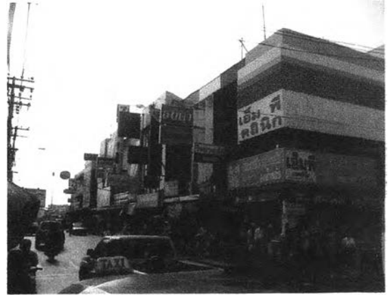
ภาพที่ 4.7 แสดงอาคารพาณิชย์บริเวณทำนายนนทบุรีซึ่งมีสีสนัการต่อเติมตกแต่งอาคารที่ขัดแย้งกันอย่างไร้ระเบียบ
