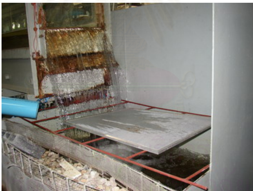
รูป ก-14 ตะแกรงสำหรับดักทรายที่ไหลผ่านฝาย
