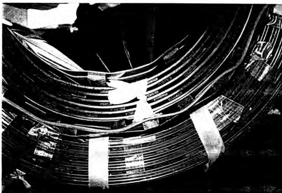
รูปที่ 4.8ค แสดงร่องระบายความร้อนระหว่าง ชุดลวดแรงสูง แรงต่ำและแกนเหล็ก
