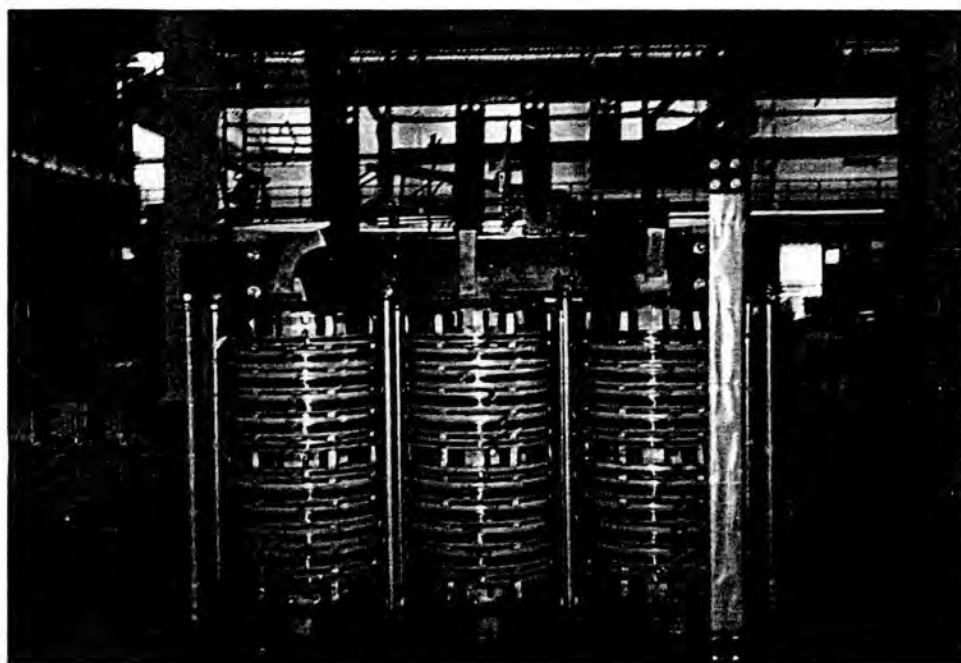
รูปที่ 4.13ก ถอดฝาหม้อแปลงออกเตรียมเข้าเตาอบ
