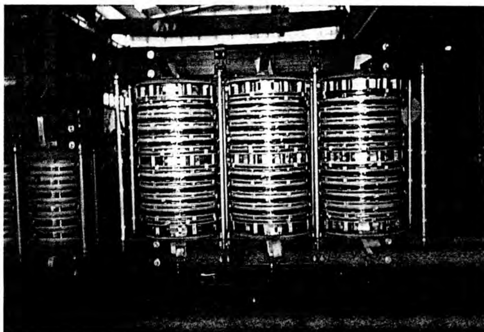
รูปที่ 4.9ง แคลมป์ด้านบนและด้านล่างยึดติดกันด้วยแท่งเหล็กกลม
