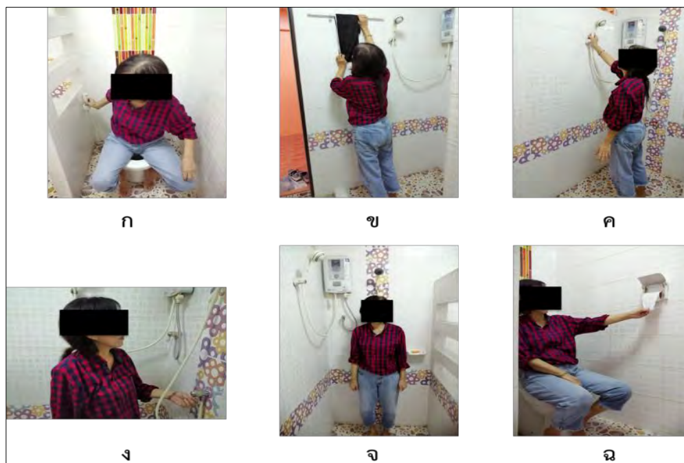
รูปที่ 1.2: แสดงตำแหน่งการติดตั้งความสูงอุปกรณ์ภายในห้องน้ำที่ไม่เหมาะสมกับสรีระร่างกาย ของบุคคล (รูปที่ 1.2 ก-ฉ)
