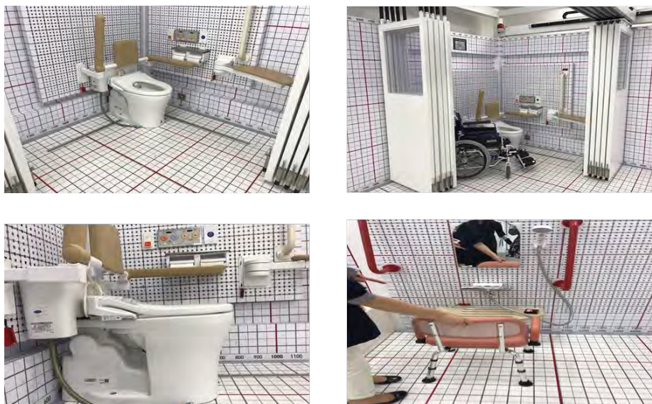
รูปที่ 1.4: ห้องสำหรับการทดลองติดตั้งอุปกรณ์ภายในห้องน้ำ (ศูนย์ TOTO Technical Center)
