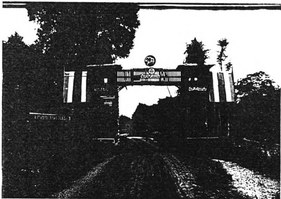
รูปที่ 4-5 ซุ้มประตูของหมู่บ้านประจักษ์ 2 แห่งในนิคม
