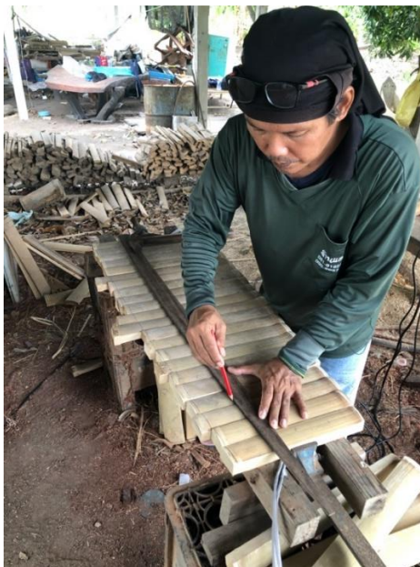
ภาพที่ 119 ช่างเกรียงศักดิ์กำลังทำทาบกระสวนตีเส้นสำหรับเตรียมเจาะรู
