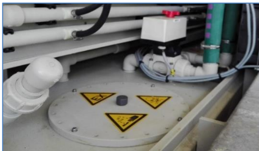
รูปที่ 2-19 ลักษณะของถังบรรจุน้ำสารละลายอิเล็กโทรไลต์
