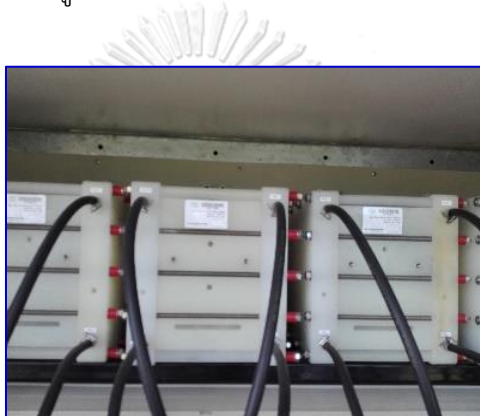
รูปที่ 2-18 เซลล์สแต็ก (Cell Stack) ของแบตเตอรี่ VRF
