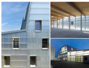
รูปที่ 2.14 ตัวอย่างผนังบ้านที่ใช้วัสดุโปร่งแสงประเภทสารอินทรีย์ [29]
