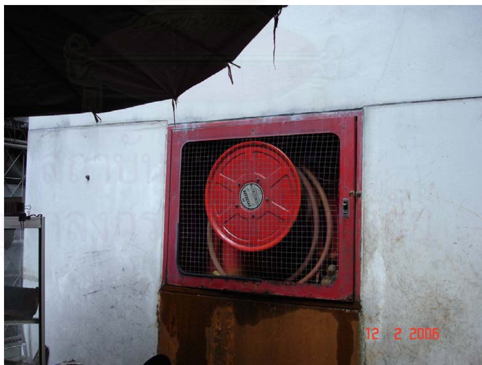
ภาพประกอบที่ 4.9 แสดงตู้ดับเพลิงในแต่ละอาคาร
