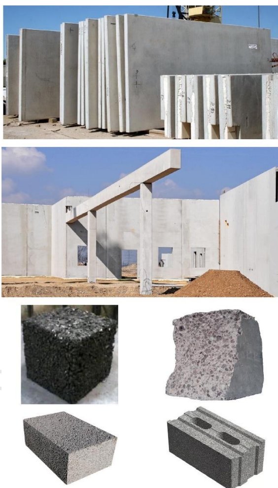
รูปที่ 5 การใช้ประโยชน์เม็ดดินเผาฟองตัวในงานคอนกรีต [56]
