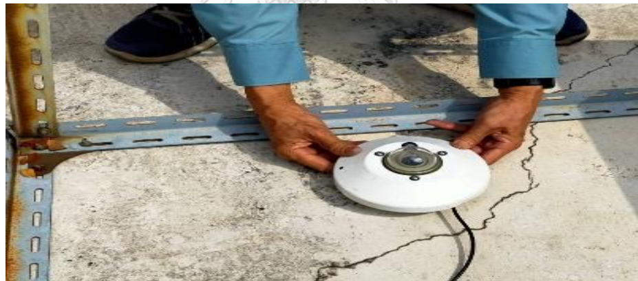
รูปที่ 3.13 การติดตั้งไพรานอมิเตอร์ในแนวระดับ
