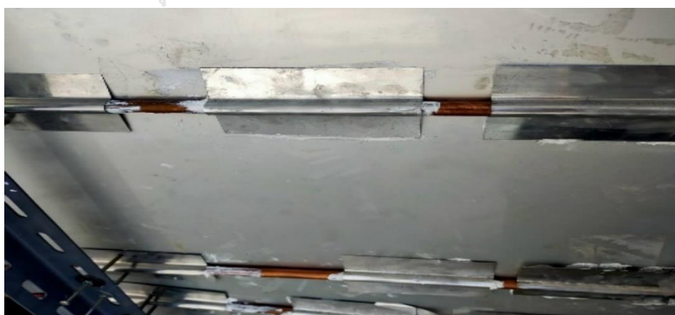
รูปที่ 3.5 ฟินของส่วนระเหยที่บริเวณด้านหลังของแผงโซลาร์เซลล์
