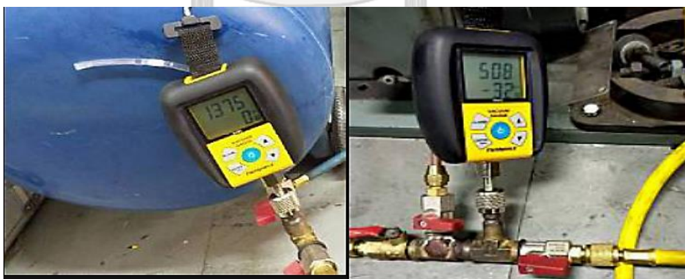
รูปที่ 3.9 ภาพก่อน - หลัง การดูดอากาศภายในท่อทองแดง
