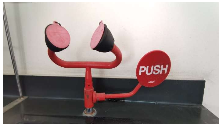
รูปที่ 3.2 อ่างล้างตาฉุกเฉิน
