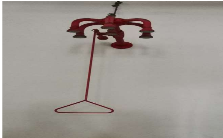
รูปที่ 3.1 ฝักบัวล้างตัวฉุกเฉิน
