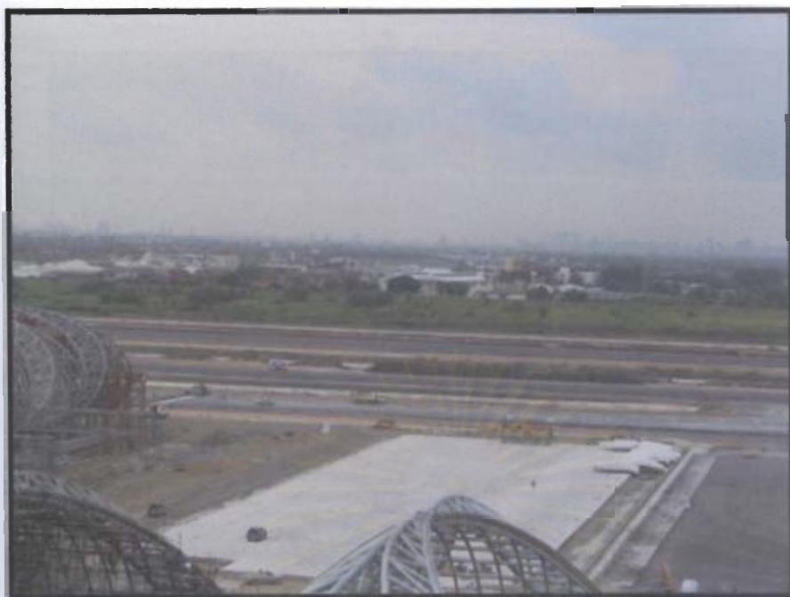
รูปที่ 1.4 งานก่อสร้างปรับปรุงคุณภาพดิน ทางวิ่ง ทางขับ ฝั่งตะวันตก และลานจอดอากาศยาน ถ่ายเมื่อวันที่ 4 สิงหาคม 2547 (ที่มา : http://www.suvarnabhumiairport.com )
