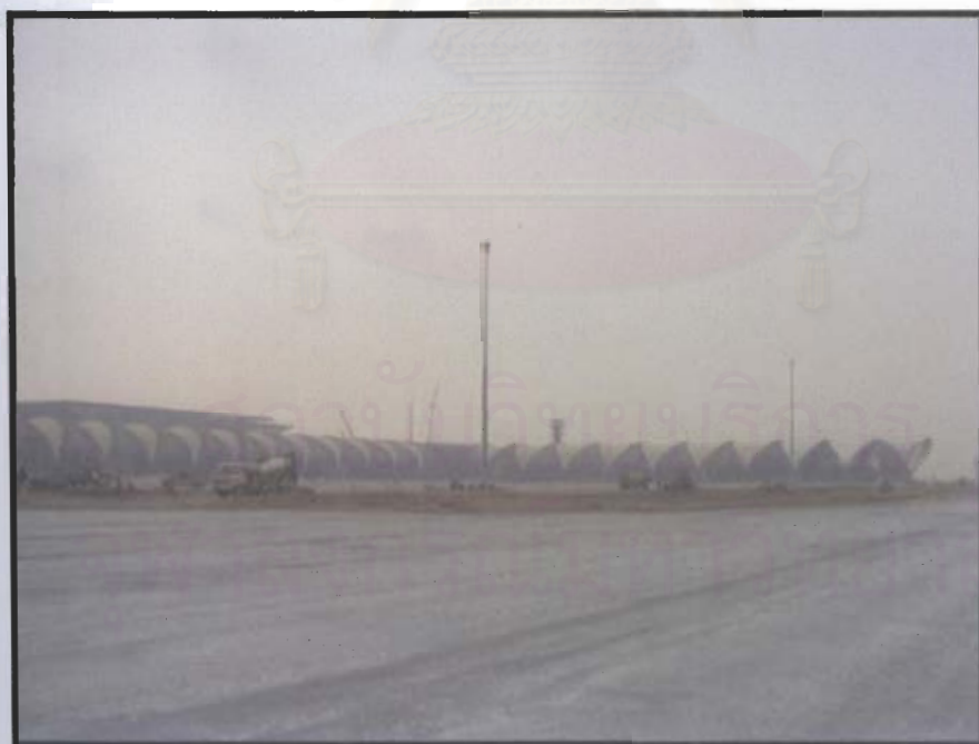
รูปที่ 1.5 งานก่อสร้างปรับปรุงคุณภาพดิน ทางวิ่ง ทางขับ ฝั่งตะวันตกและลานจอดอากาศยาน ถ่ายเมื่อวันที่ 21 มกราคม 2548 (ที่มา : http://www.suvarnabhumiairport.com )
