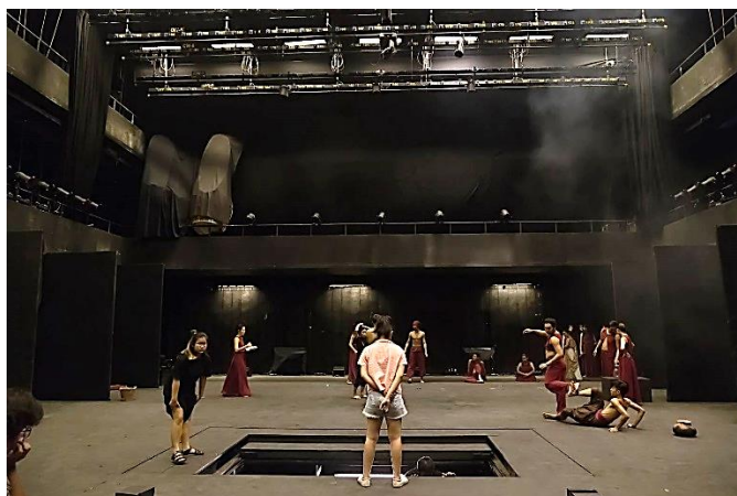
ภาพที่ 90 ภาพการทดลองสูบไฮดรอลิกลง
