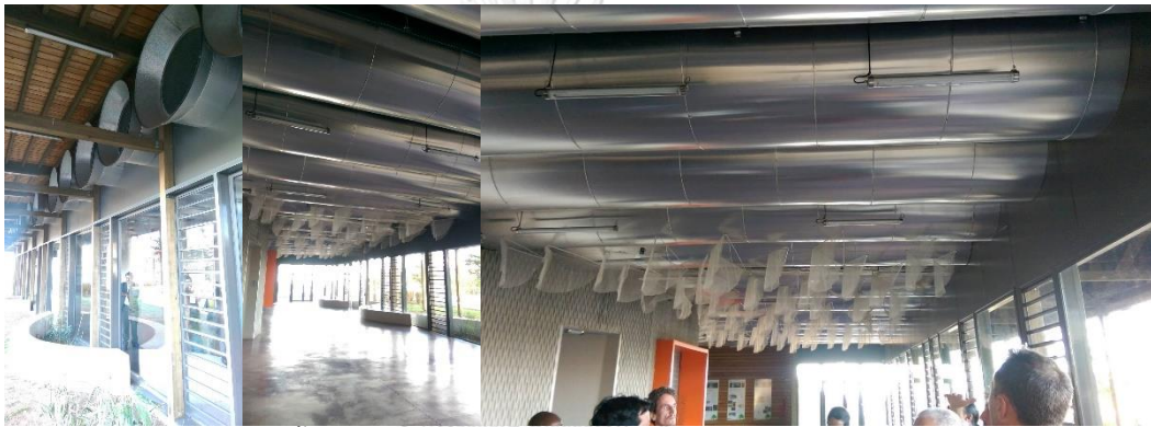
ภาพที่ 2.13 ตัวอย่างการติดตั้งระบบท่อระบายอากาศในอาคารเรียนแห่งหนึ่งที่เกาะ Reunion, ประเทศฝรั่งเศส
