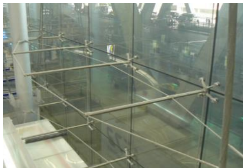
รูปที่ 1-1 ลักษณะทั่วไปของการติดตั้งกระจกด้วยตัวยึดต่อกระจกชนิดรูเจาะ
