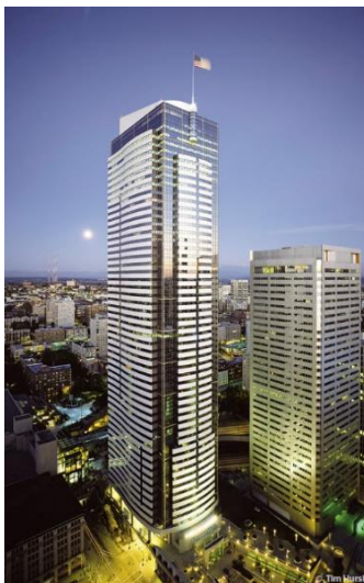
รูปที่ 2.7 อาคาร Two Union Square building
