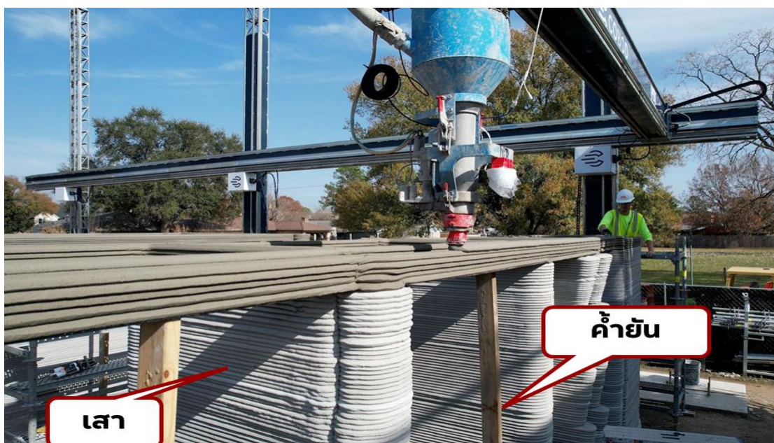
รูปที่ 2 ตัวอย่างลักษณะการพิมพ์ 3 มิติด้วยคอนกรีต (Garcia, 2023)
