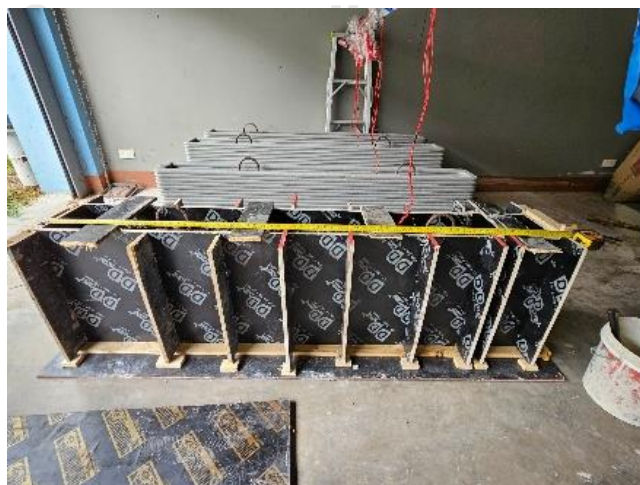
(ค) ลำดับที่ 3: ยกเหล็กคานใส่ในกรอบแบบ
