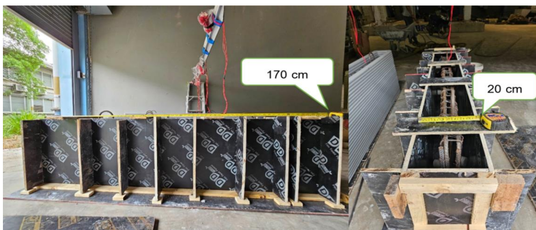
รูปที่ 60 กรอบไม้แบบคานคอนกรีตปกติ (NB)
