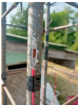
(ก) การติดตั้ง Strain gauge สำหรับติดเหล็ก
