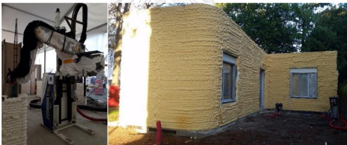
รูปที่ 41 เครื่องพิมพ์ 3 มิติ และการพิมพ์ Yhnova™ (Furet et al., 2019)
