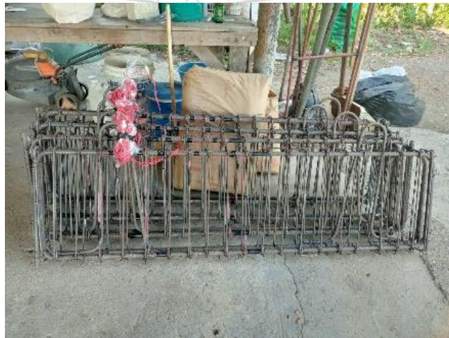
(ข) ลำดับที่ 2: การติดตั้ง Strain gauge สำหรับติดเหล็ก
