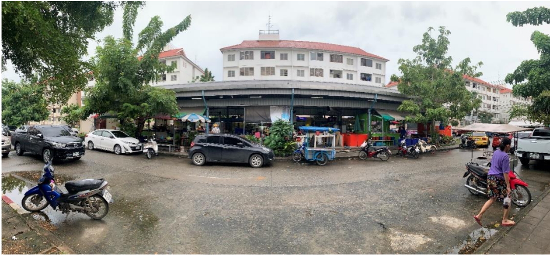
ภาพที่ 18 ด้านข้าง(ทิศเหนือ) ตลาดโครงการบ้านเอื้ออาทรลาดกระบัง 2 ตลาด L3
