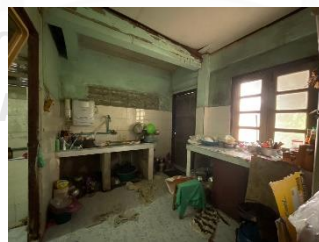
รูป 2 ห้องครัว/ส่วนครัว
