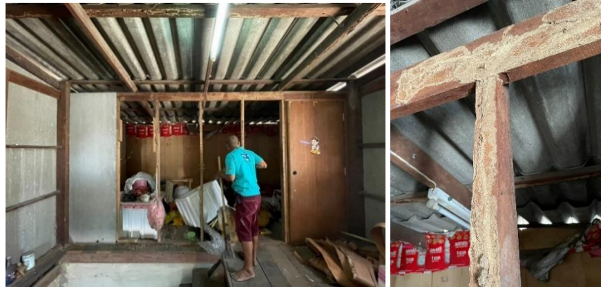
ภาพ 6.1 บ้าน M7 สภาพบ้านทั่วไปทรุดโทรม จากปัญหาปลวก และปัญหาปลวกในโครงสร้างไม้ ที่มา: ผู้วิจัย (2566)
